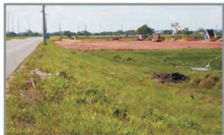
(c) Um dos aterros na área alagável do Rio Macaé (às margens da Linha Azul) para atender a expansão das atividades econômicas ligadas, principalmente, à economia do petróleo, em 10 jun. 2010 Foto: Francisco de Assis Esteves
