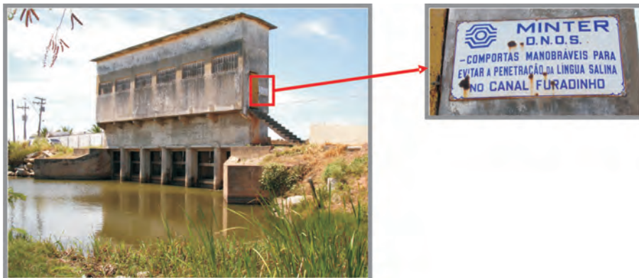
Figura 5.2 - Comportas de controle da entrada de água do mar nas terras baixas de Farol de São Tomé, no Canal Furadinho (Campos dos Goytacazes) Foto: João Marcelo S. de Sousa (16/01/2010)
