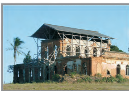
(b) Ruína do Solar Machadinha, município de Quissamã.
